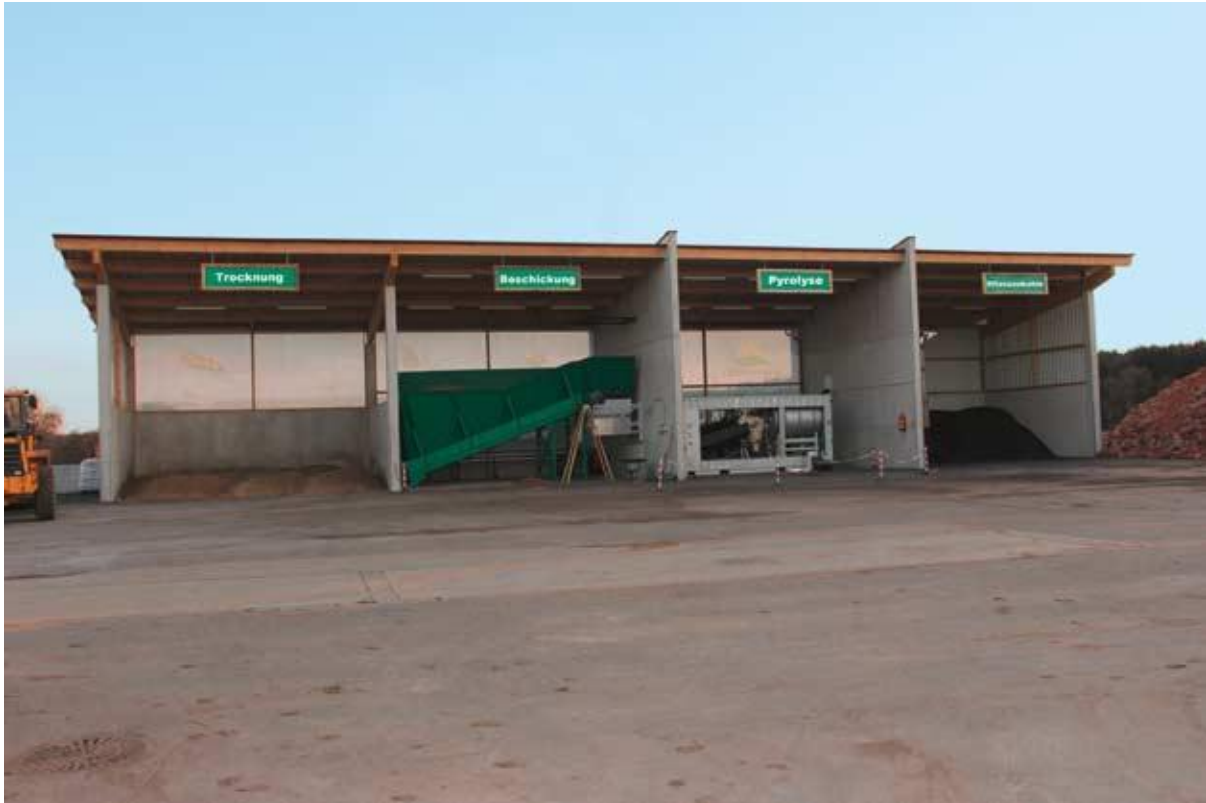
Фиг.14. Площадкови инсталации за опозотворяване на “зелена биомаса” и утайки от ПСОВ.
