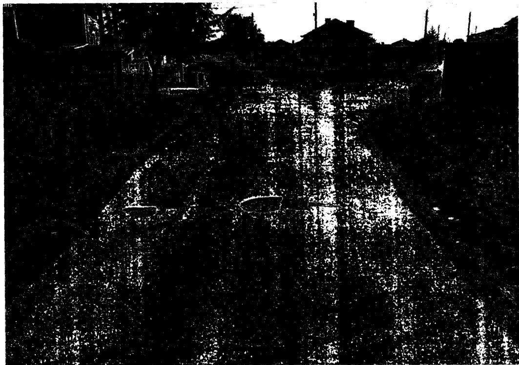
1.2. Силно деформирана асфалтова настилка, нарушено покритие и слягания
